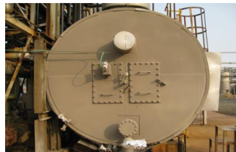
Incinerator（焚化炉）涂层后 55℃
